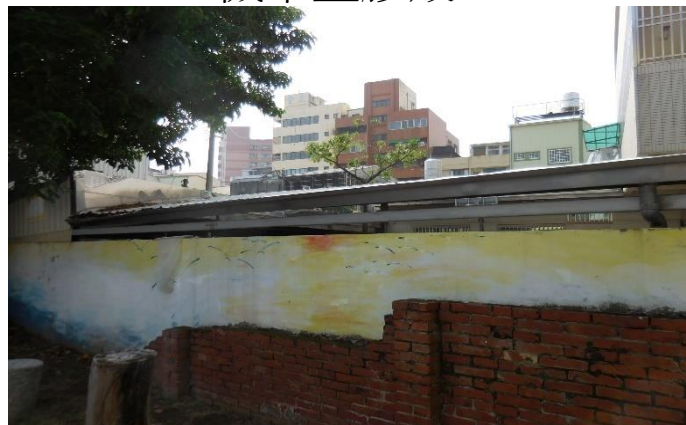
天溝(屋簷排水槽)
