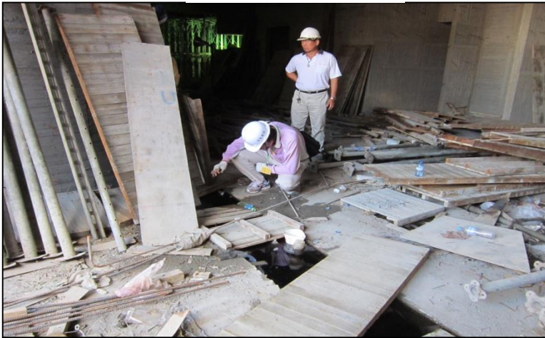
車道下方水溝
