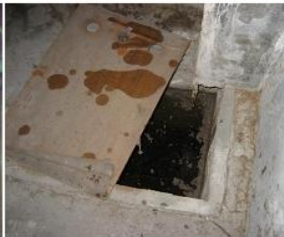
地下室污水池
