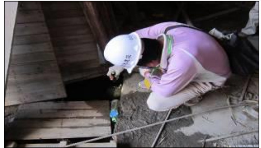
車道下方水溝
